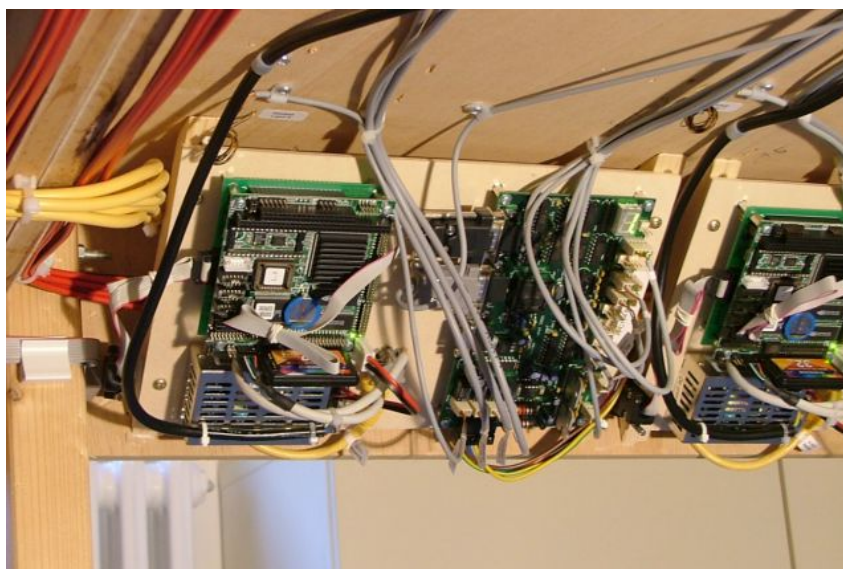
Abbildung 4.3: PC104-Modul in der Anlage
