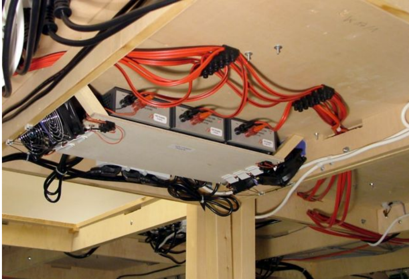
Abbildung 4.9: 12 Volt-Schaltnetzteile unter der Anlage
